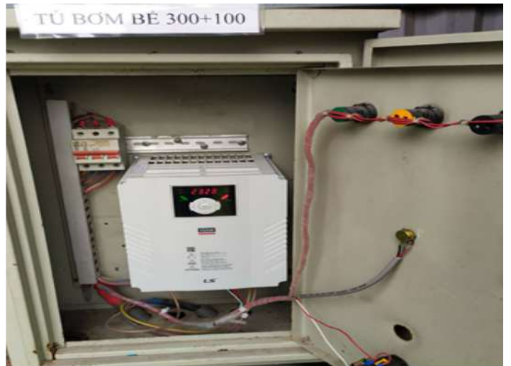
엠씨넥스 VINA 인버터 설치
