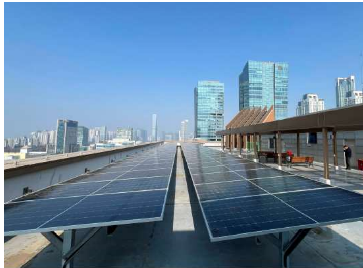
태양광 패널 설치
